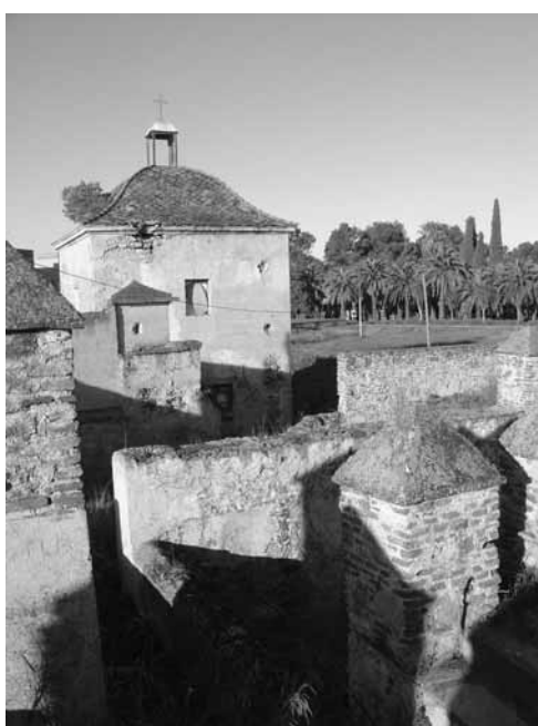
Fig. 9. Conjunto de los restos desde la Puerta del Alpéndiz hasta el pabellón de Autopsias, probable ubicación de las casas de la encomienda (Serafin Martín Nieto).
