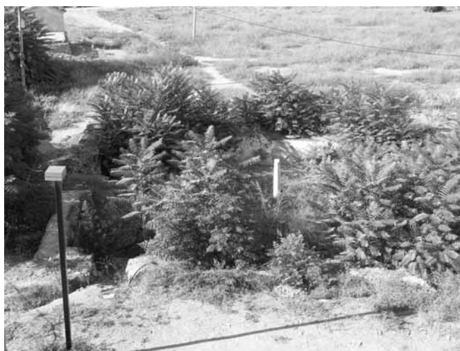
Fig. 19. Santa Maria de los Freiles. Cuerpo de la iglesia invadido por la vegetación (Bartolomé Miranda Diaz).
